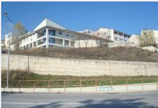
Νέα κτίρια Τμήματος Γεωπονίας
