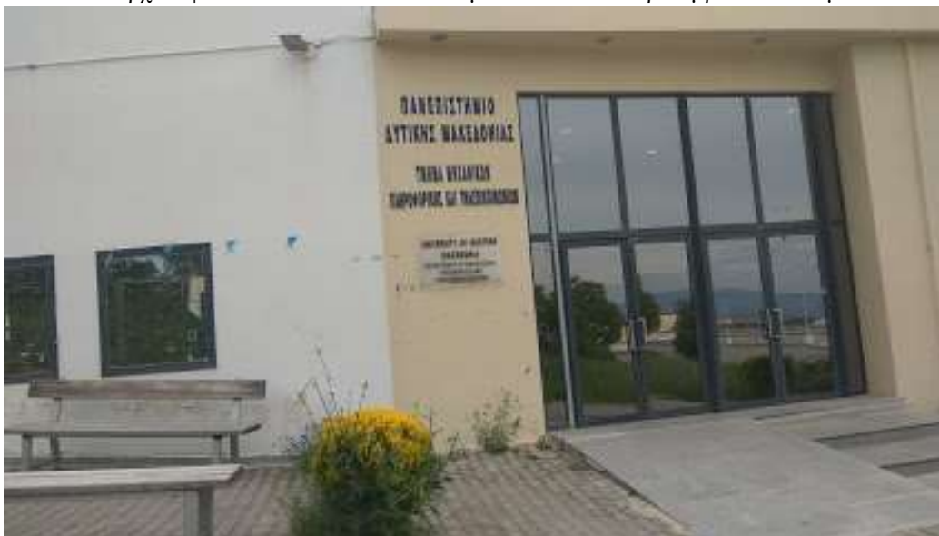
Εικόνα 17. Το κτήριο του ΤΗΜΜΗΥ στην Κοζάνη
